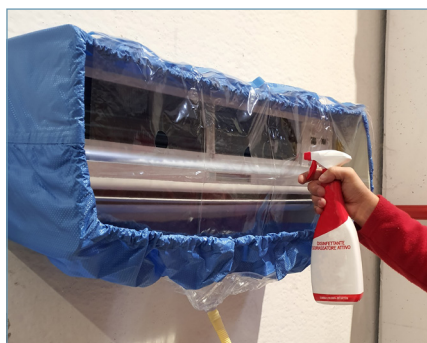
Pulizia batteria con telo di protezione applicato
