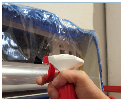
Pulizia batteria tramite foro inserimento spruzzino
